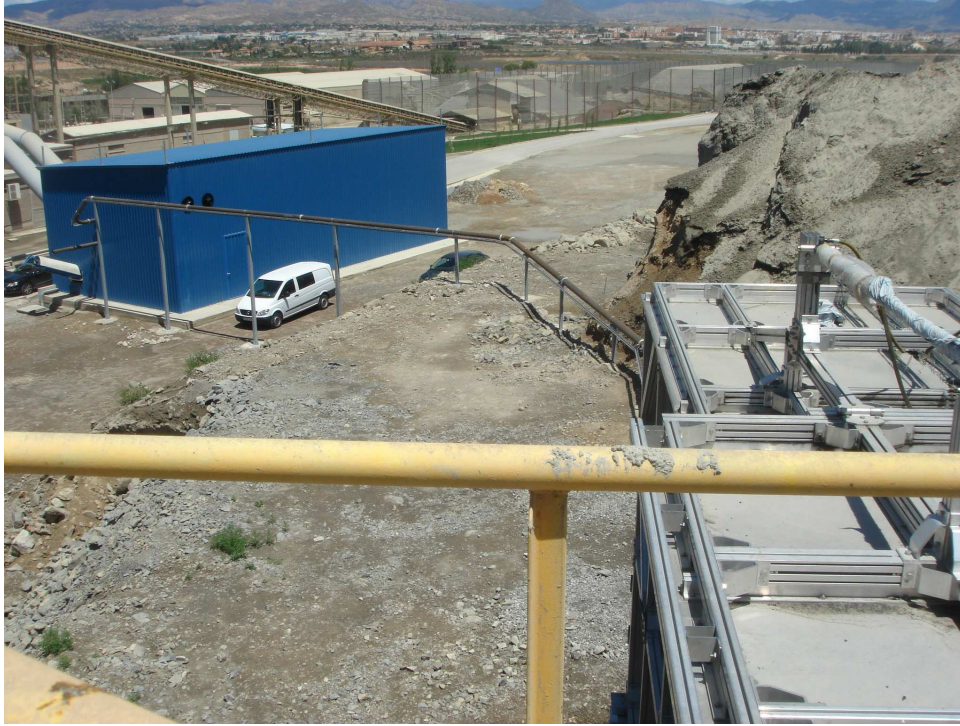
Construcción planta piloto.
